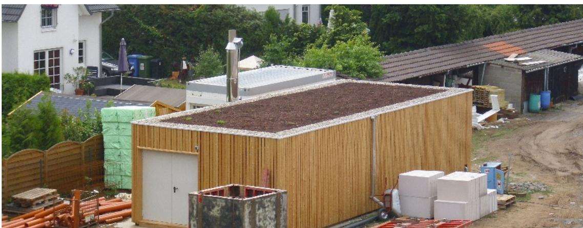
Die Energiekabine. 320 kWh Pelletheizung für 96 Wohneinheiten. Foto: Energiegenossenschaft Pfungstadt
